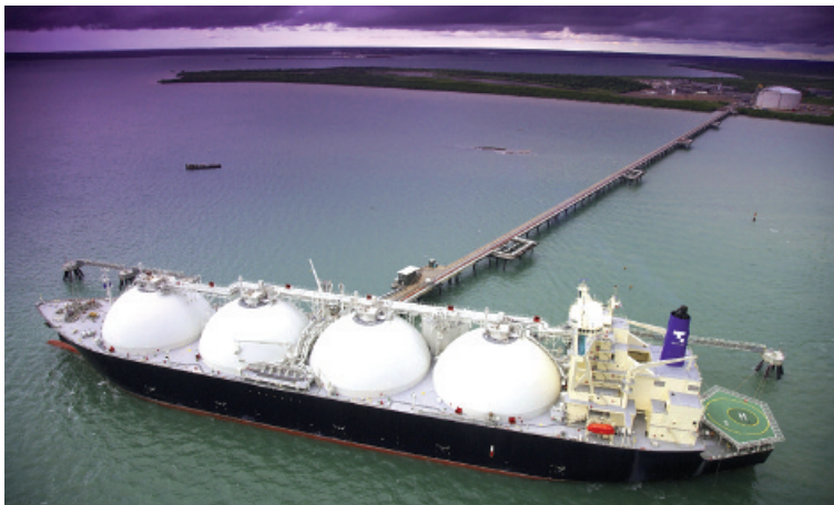
LNG tanker loading at Darwin LNG plant.
